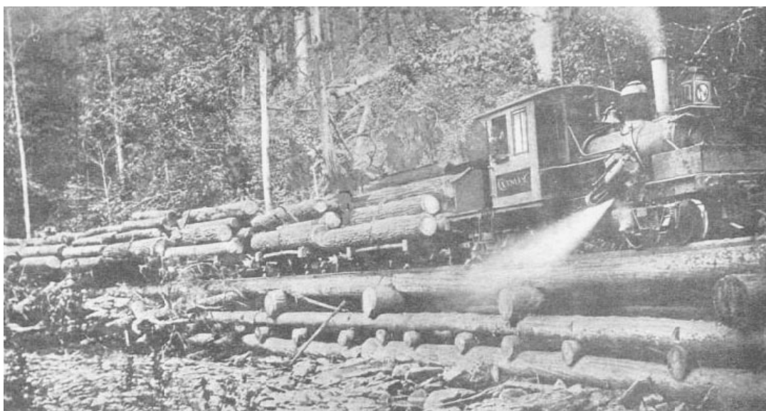
Fig. 117 - Locomotora Climax de 20 toneladas y dos bogies en servicio en West Virginia, donde tenía pendientes de 150 % y radios de 40 metros. Nótese las ruedas cóncavas sobre rieles de troncos.
